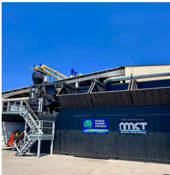
Overview of MCT Italy Batch Plant in Adelaide, SA Gesamtansicht der Mischanlage von MCT Italy in Adelaide, SA
